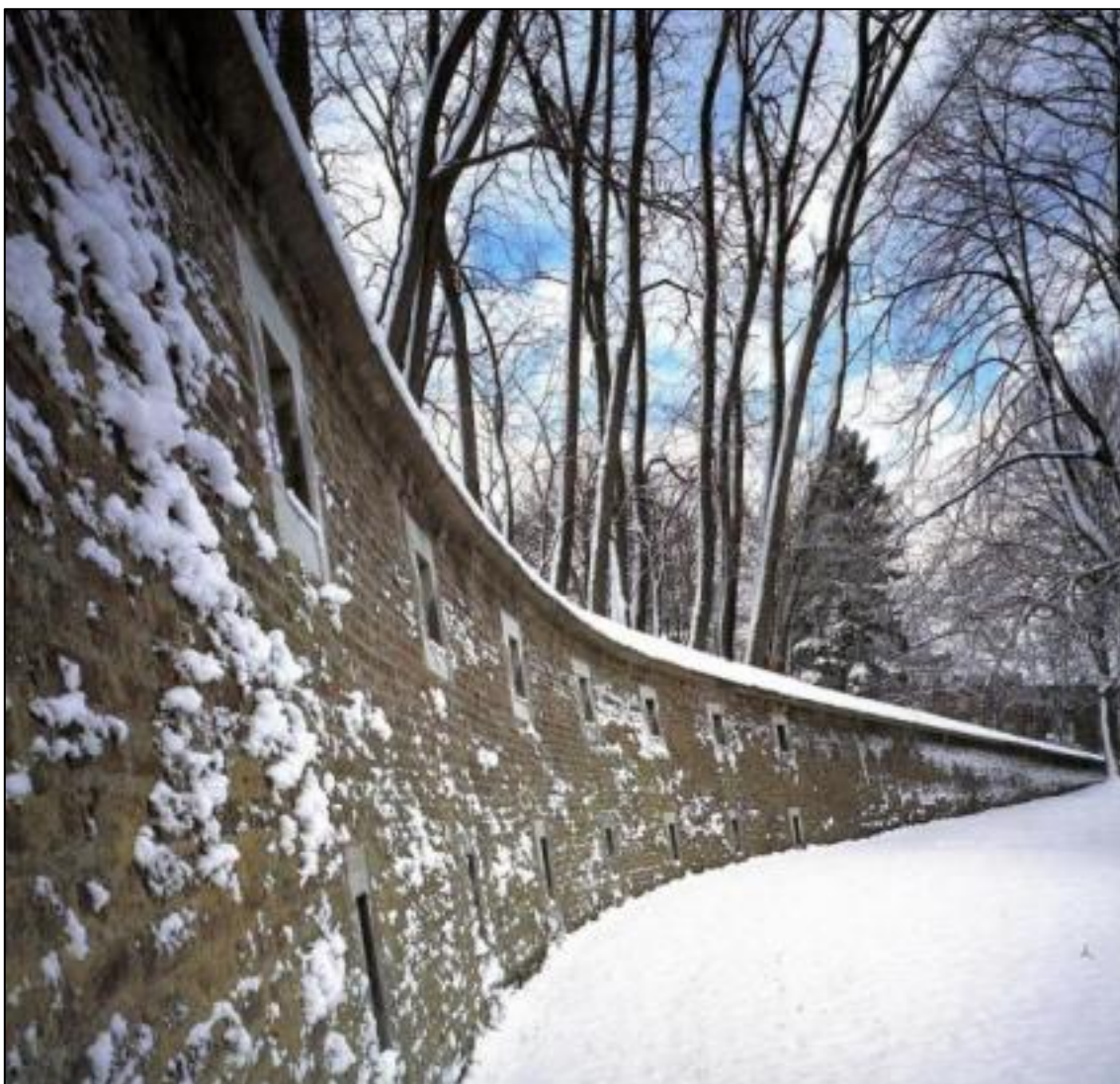
Figuur 10: recente foto van Bastion Waldeck in het winterseizoen.
